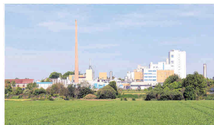
Das Werk Wasserburg von Edling aus gesehen mit dem neuen Trockenturm.
